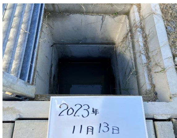
最終集水桝（場内）
