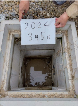
最終集水桝（場内）
