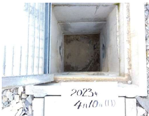
最終集水桝（場内）
