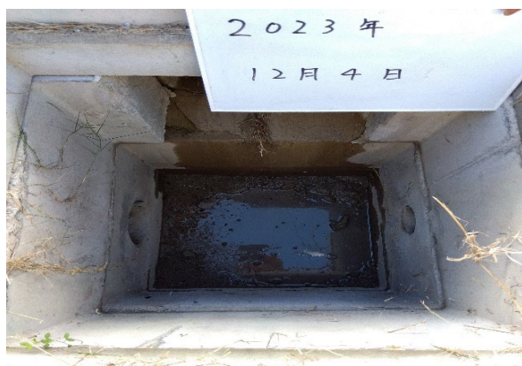
最終集水桝（場内）
