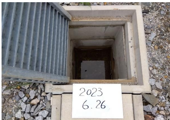
最終集水桝（場内）
