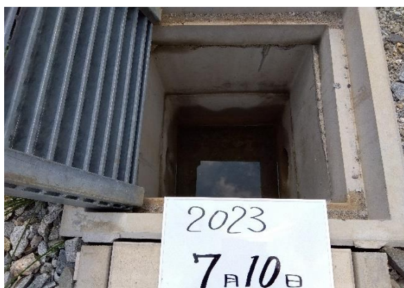
最終集水桝（場内）
