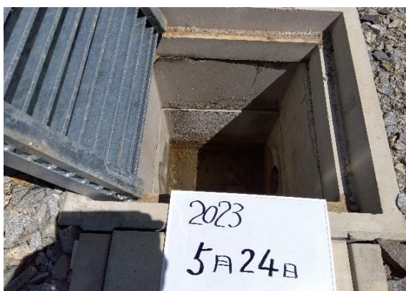
最終集水桝（場内）
