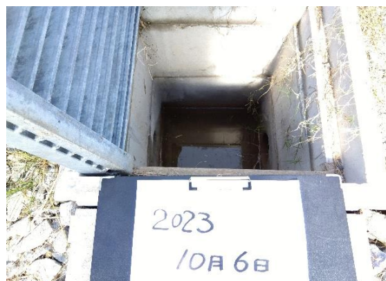
最終集水桝（場内）
