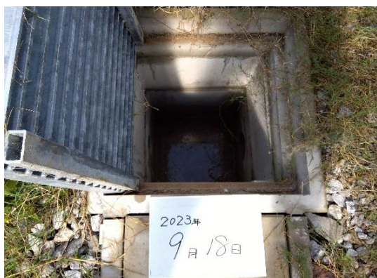
最終集水桝（場内）
